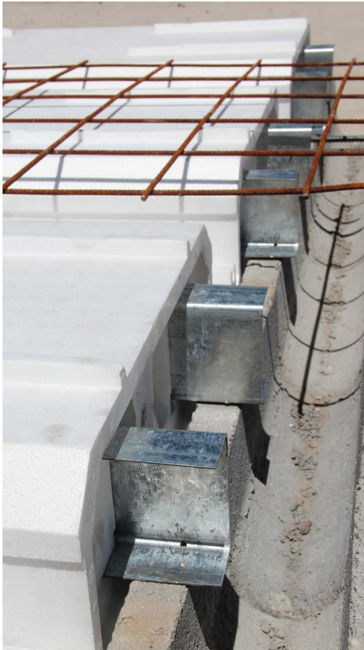
Bloque de EPS con alma de acero galvanizado doblado en frío.
