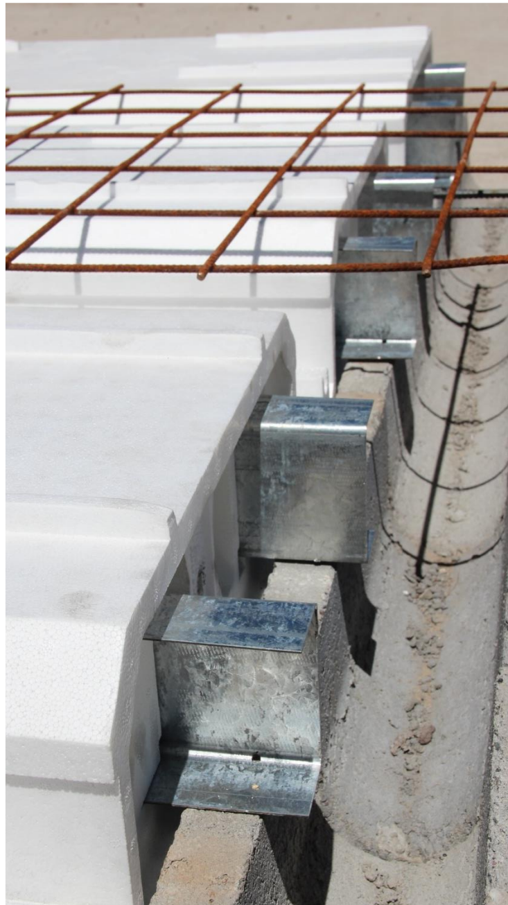
Bloque de EPS con alma de acero galvanizado doblado en frio.
